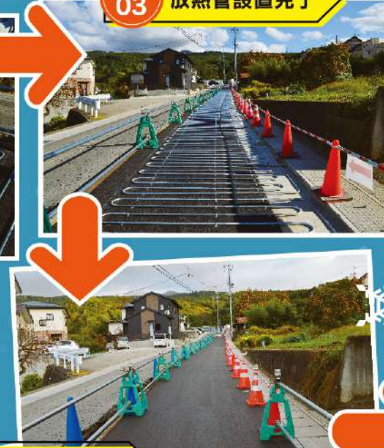
工程 04 アスファルトで舗装
