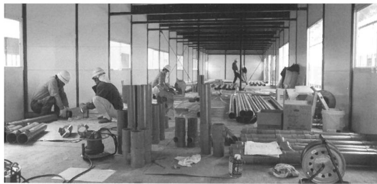
▲仮設住宅内部配管状況
