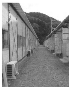
▲仮設住宅完成外観
