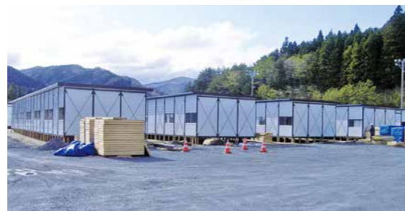
岩手県三陸町にてプレハブ住宅の設置
